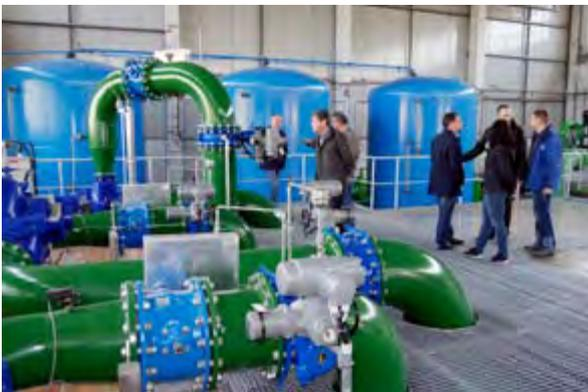
Vertreter vom Kommunalen Energienetzwerk Cottbus konnten sich in diesem Jahr bei ihrem Besuch im Wasserwerk Cottbus-Sachsendorf selbst von der energiesparenden Fahrweise der Anlagen überzeugen. So wurden u. a. drei neue Rohwasserzwischenpumpen mit der Photovoltaikanlage gekoppelt, die die LWG seit November 2013 auf dem Gelände des Wasserwerkes Cottbus-Sachsendorf betreibt und damit jährlich rund 30 % an Stromkosten im Wasserwerk spart.
